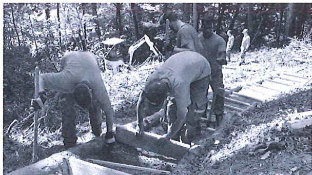
Die Trittplatten werden eingefügt.
