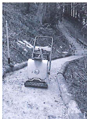
Bei der neu erstellten Treppe fehlen nur noch die Geländer.
